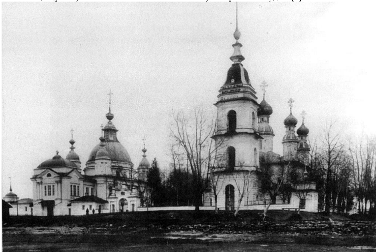
Рисунок 4. Церковь Николая Мирликийского, Церковь Воскресения Христова, 1763-1773 гг., ул. Пролетарская, 1. Архивное фото
